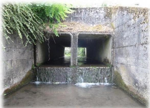
Photo avant travaux – Ouvrage infranchissable au niveau de la route départementale © CCVG
