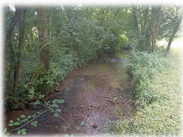
Photo avant travaux – Substrat argileux, lit recalibré trop large et écoulements peu diversifiés © CCVG
