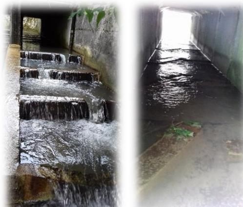
Photos après travaux – Passe à poissons et déflecteurs sur le radier du pont © CCVG
